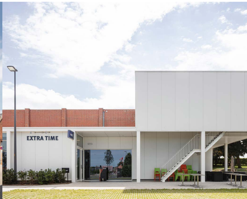
Renovatie sporthal Ichtegem. Claeys-Haelvoet architecten. Foto: Tim Van de Velde
