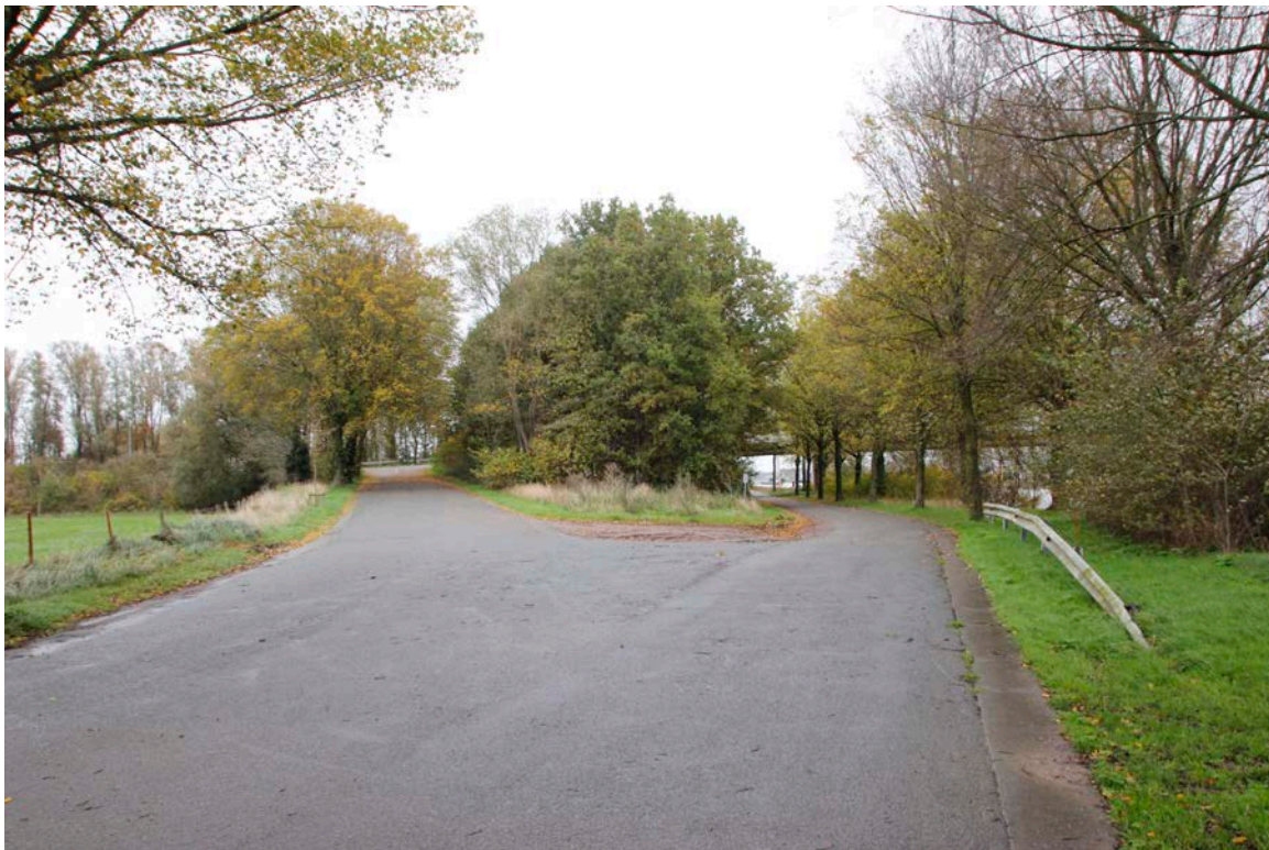
Verknoping tussen jaagpad en viaduct (ter hoogte van kanaalbrug N375)
