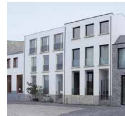
Door de begane grond iets op te tillen t.o.v. de straat ontstaat op een aantrekkelijke wijze distantie tussen de woning en de openbare ruimte (Meta Architecten, Antwerpen).
