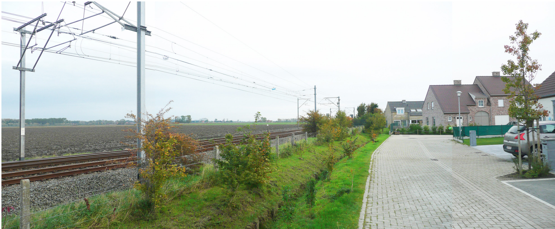
> zicht op de spoorwegberm vanuit de verkaveling Huyzentruyt
