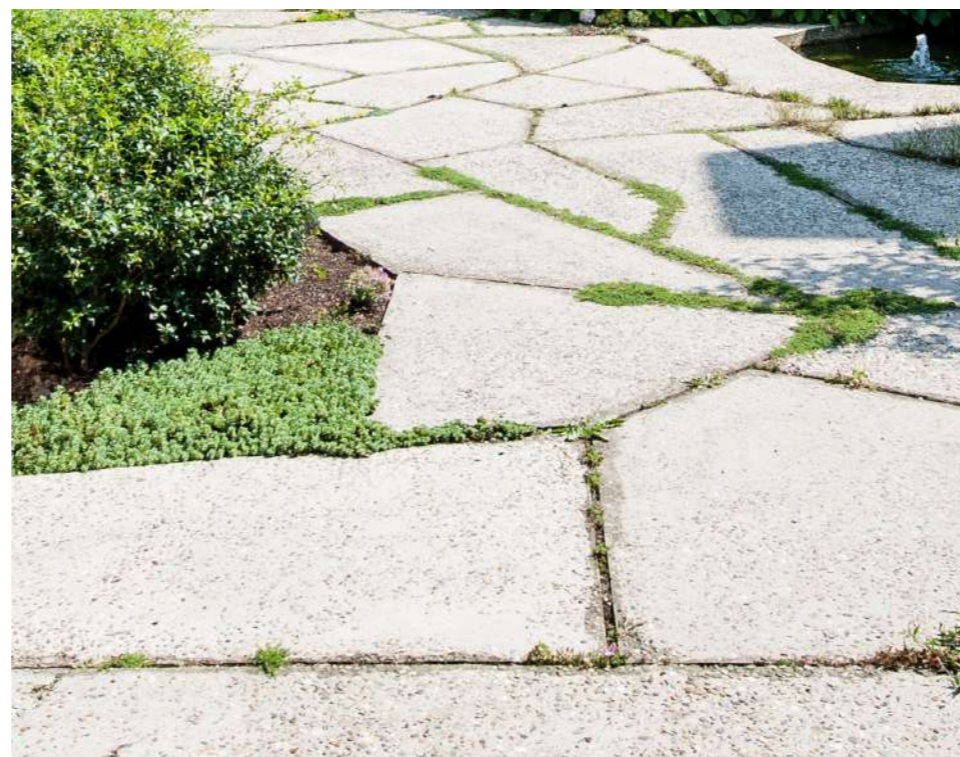
Referentie groene voegen tussen betonnen veelvlakken
