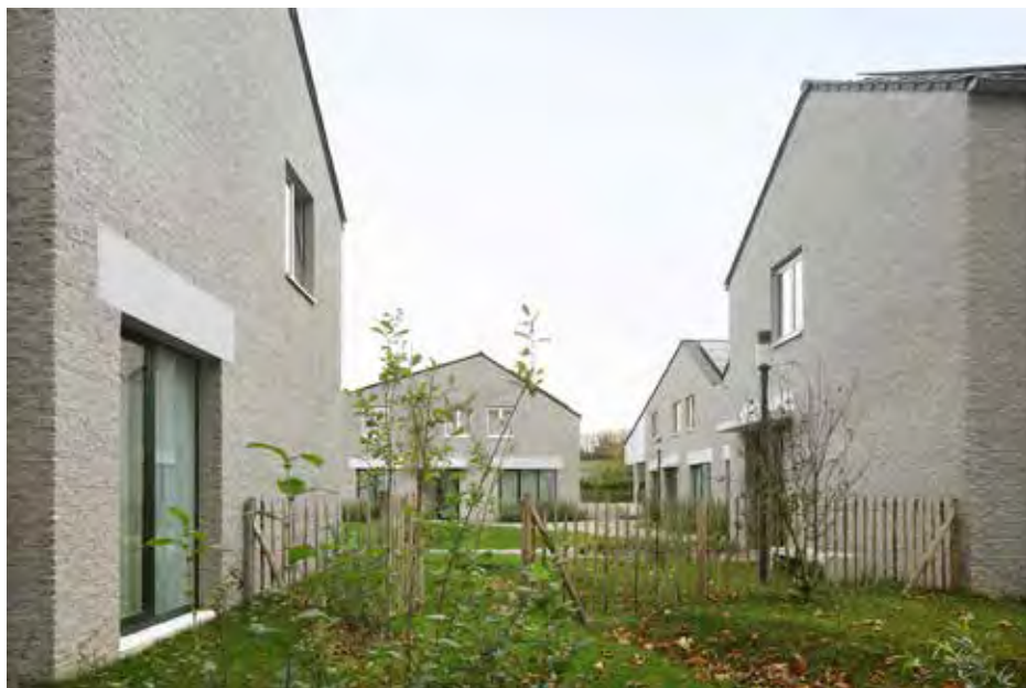
erfwoningen, Leupegem - ectv architecten
