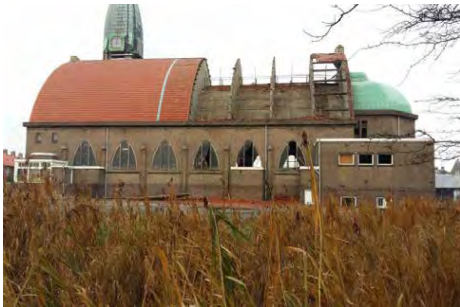
O.L.V. Geboortekerk, Halfweg - Kentie en Partners architecten
