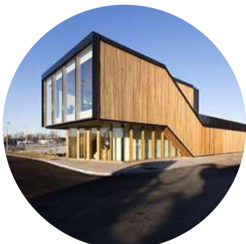
Bezoekerscentrum Gentse Havenbedrijf, Tetra architecten
