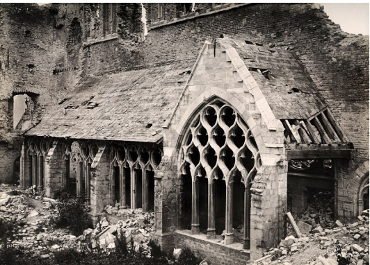
Het kloosterpand tijdens de restauratie, 1912-13
