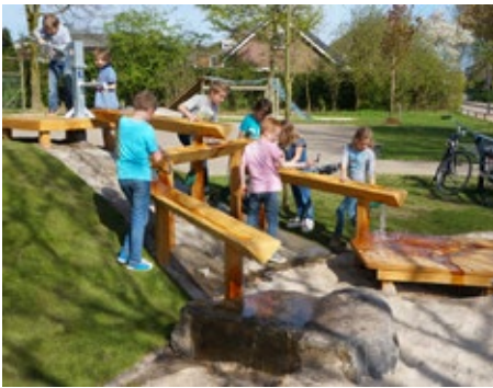
Water van het aquaduct wordt element van spel, waarna het infiltreert in de ondergrond
