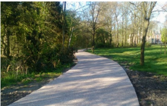
Pad uit uitgewassen beton
