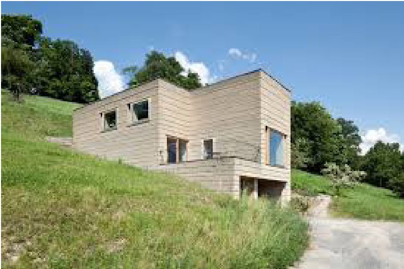
Cut and Fill: de uitgehouwen aarde uit de heuvel is verwerkt tot bouwgrondstof Haus Rach, Vorarlberg
