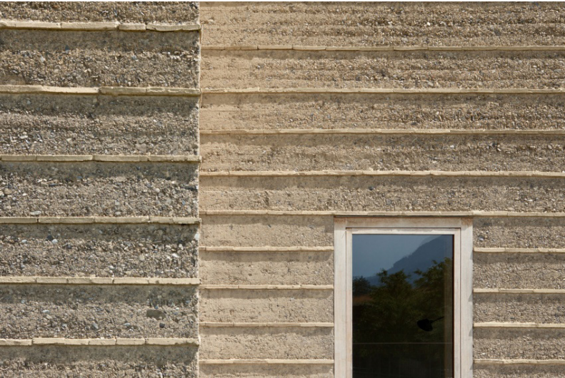
Tegelstrips tegen het afwaassen van de buitenste centimeters
