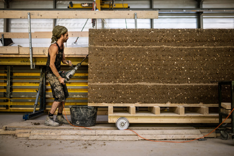
prefab- rammed earth wanden voor het Ricola Centrum
