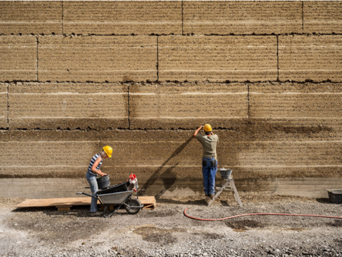
vullen van de prefab voegen on site
