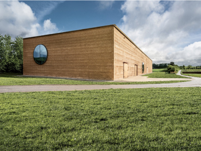
wanden in rammed earth, prefab in een loods gemaakt
