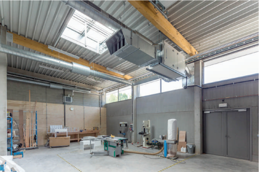
referentie Bureau Partners - Wegendepot te Ternat
