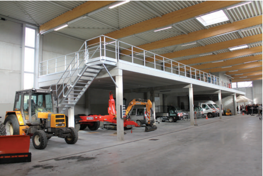
referentie Bureau Partners - Technische Cluster te Liedekerke
