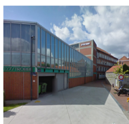
Baertshof en hoekpand Strobbe, fabrieksgebouw Strobbe, zuidelijke campus met vrederecht en de post, historische dreef Kasteelstraat, gebouw belastingsadministratie vanaf Dirk Martenslaan, Kasteelstraat en fietsdoorsteek (in wijzerzin)
