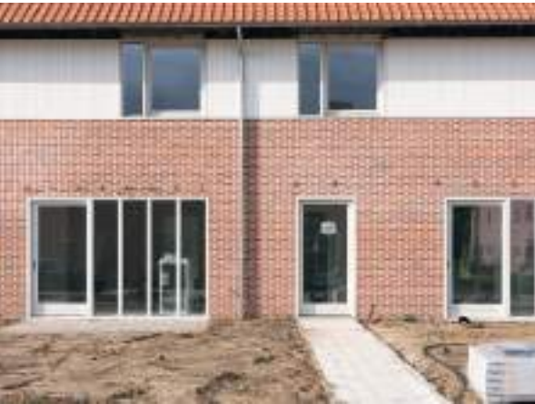
Goed gekozen vaste raamkaderproporties met waar nodig opendraaiende delen. Een stevige baksteen sokkel met daarboven een geschilderde houten gevelafwerking. De gevels van Marie José Van Hee voelen tegelijkertijd origineel en vertrouwd.
