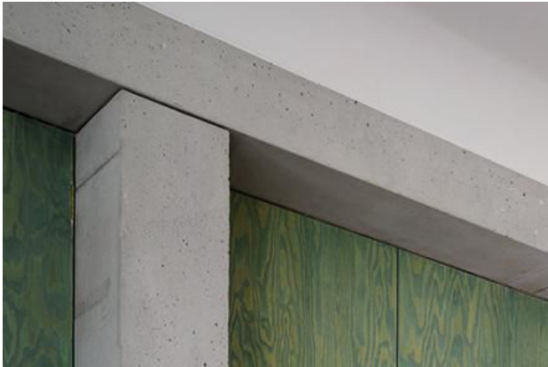
compositie van robuuste, eenvoudige materialen: beton, schilderwerk en groen gebeitste multiplex
