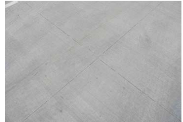
zaagsnedepatroon licht betonplein
