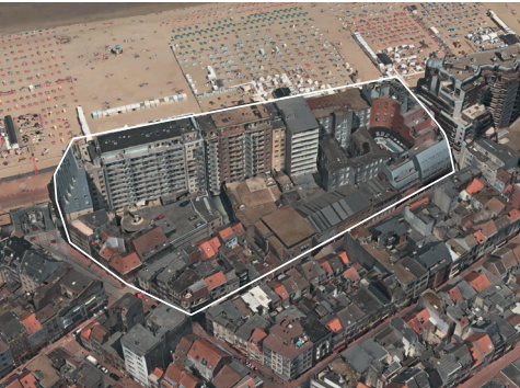
Complex bouwblok bepaald door: de zeedijk, de Weststraat, de Breydelstraat en de Bakkersstraat
