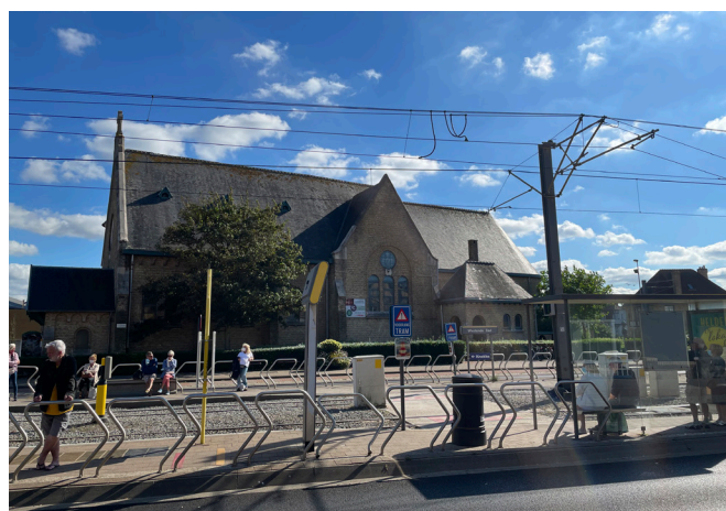
zicht op de langse zijde kapel vanaf de tramhalte
