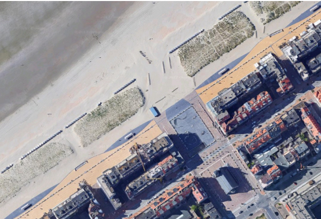
Luchtfoto heraangelegde dijk en Leopoldplein
