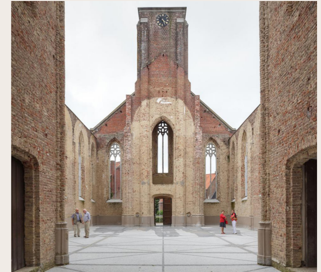
Kerkgebouw Bossuit Sileghem & Partners i.s.m. Ellen Harvey Foto: Stijn Bollaert
