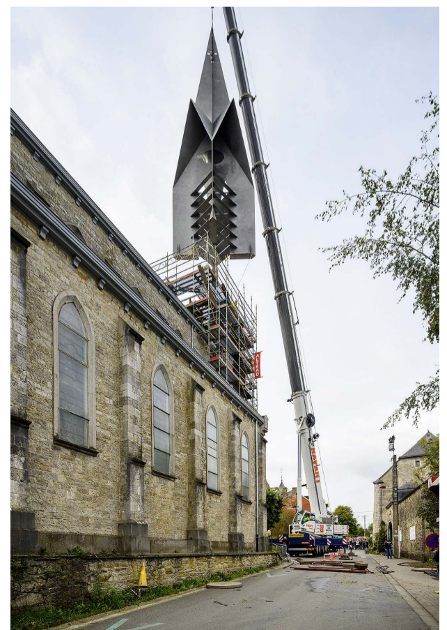
Vervanging klokkentoren Sint-Martinkerk, Ferrières
