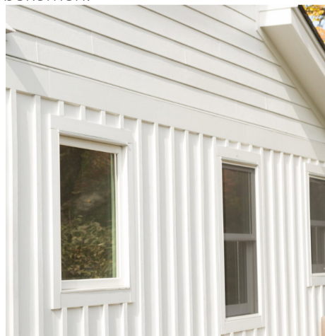
typische Amerikaanse "cladding" met vezelcementplanken en hier in beide
