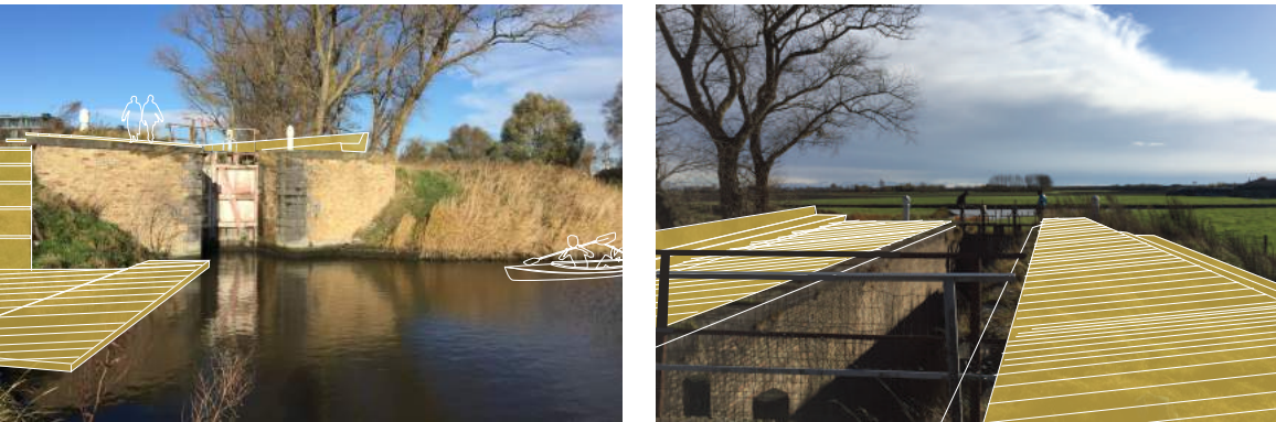
Verkenning sluisje als gebruiks en uitzichtspek
