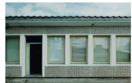
Referentie: BKO Kortemark, voor renovatie door B-ILD Architecten
