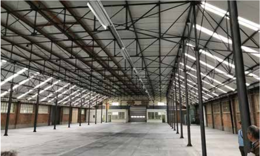
↑BESTAANDE SITUATIE: TUSSEN LOODS
