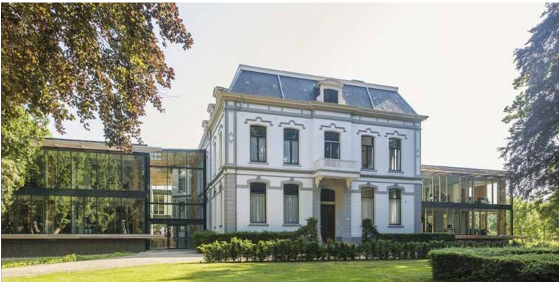
↑REFERENTIE NIEUWBOUW IN COMBINATI MET RESTAURATIE VILLA
