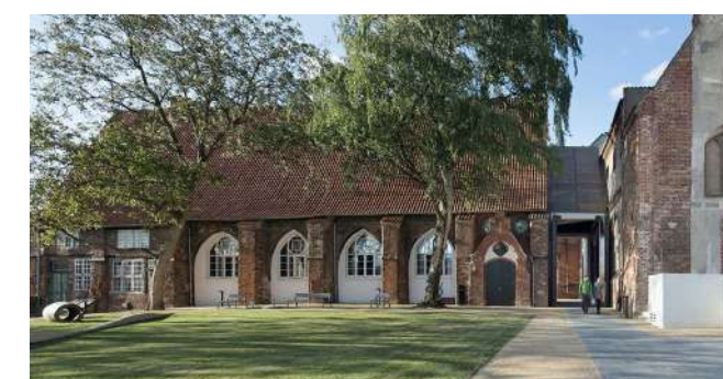
Aansluiting met historische site
