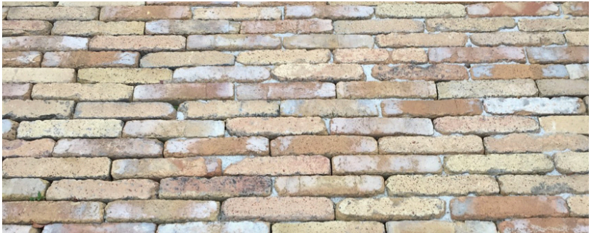
Hard gebakken gele kustbaksteen (Kleiklinkers)
