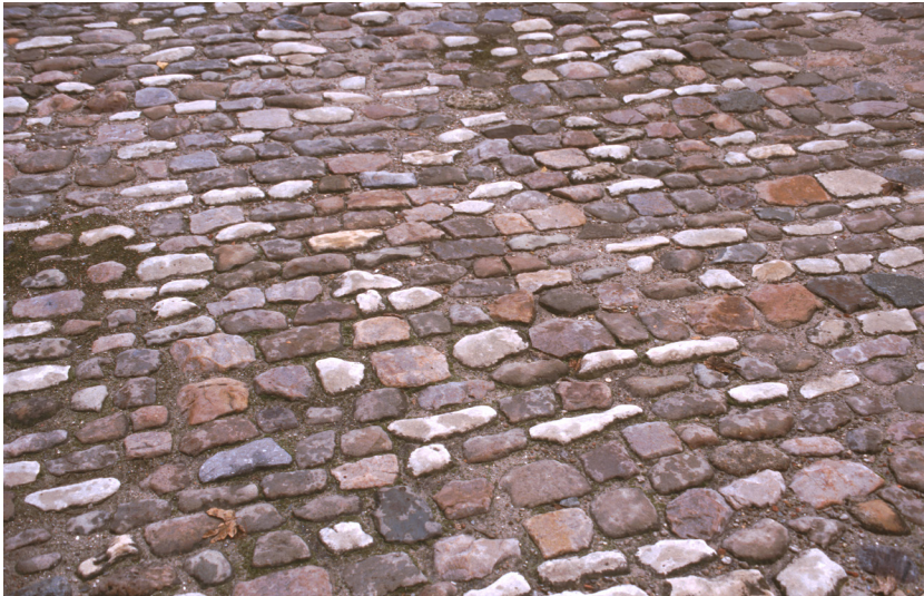
Veldstenen op het binnenplein van de site Hof Lanchals te Brugge, opgevoegd met gele grind.
